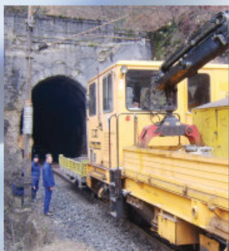
Završena sanacija tunela Ivan
